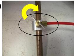
3. 用一個塑膠器皿盛在底下，套上板手，順時針方向旋轉扭開過濾芯(這時需要稍為用力)。由外往裡把需要更換濾芯的外殼逐一拆除。
